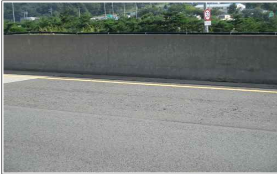
교면포장 하행선 A2측 접속도로 라벨링
