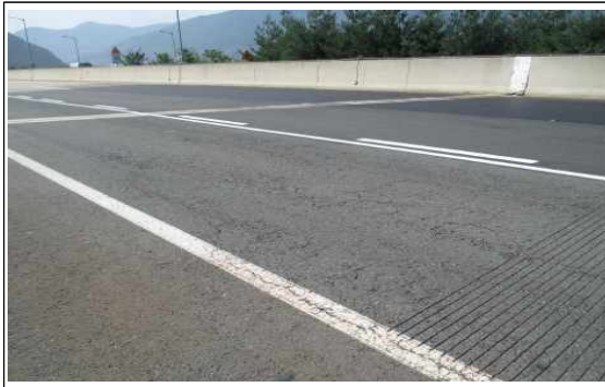
교면포장 상행선 S1 라벨링
