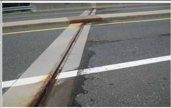
교면포장 청도방향 S1(A1) 라벨링 및 체수
