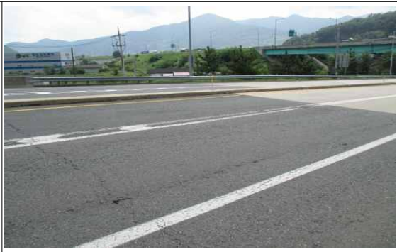
교면포장 고속도로방향 A2측 접속도로 라벨링
