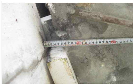
바닥판하면 상행선 S1(A1) 유간 측정
