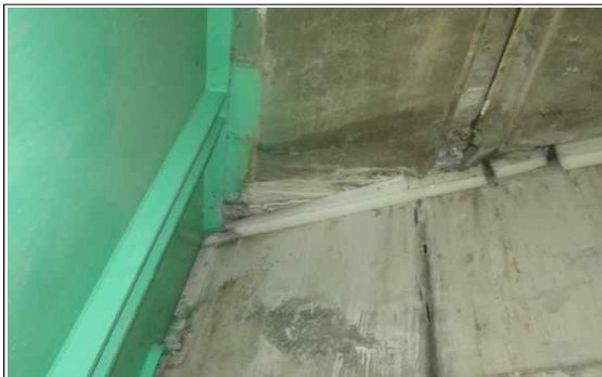
바닥판하면 상행선 S1(A1)
